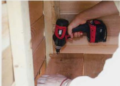
**17** 棚受けに棚を乗せ固定します。内側からゆがみ直しながらビスを打ち込みます。
