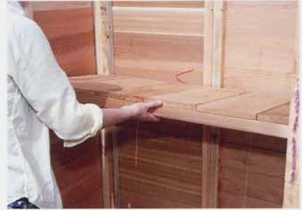
**10** 棚を仮置きします。5ヵ所の棚受けに均等に棚がかかるように調整します。
