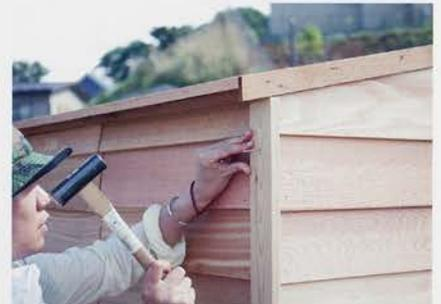
**19** 後壁板と左右壁板の合わせ目に後ろトリムを打ち付けます。
