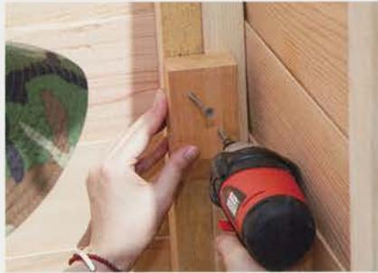
**9** 壁板に2個、後壁板に1個の棚板受けを同じ高さになる位置にビス留めます。
