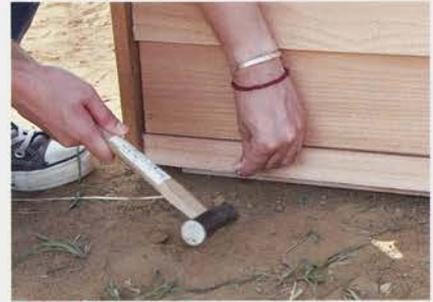
**13** 壁板の下に雨(雨の跳ね水)の浸入を防ぐための底部巾木を取り付けます。
