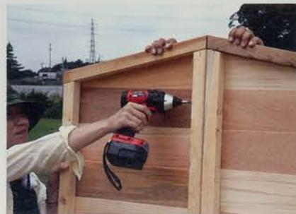
3 壁板同士をジョイントします。2枚の高さ、フレームをそろえて、留めていきます。
