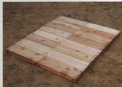
2 水平、長さをそろえた床板に、左右壁板、後壁板を接続して立ち上げていきます。
