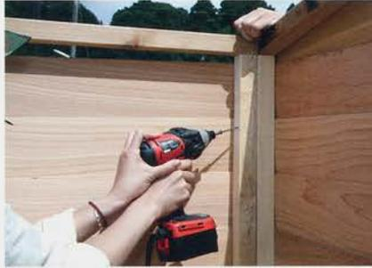
**6** まずは床板に接続し、続いて壁板に留めます。フレーム同士すき間のないように。
