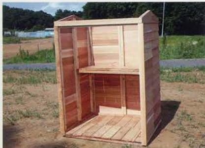
**14** 屋根を取り付ける前に全体の形を確認。ここで微調整をしてゆがみを正します。
