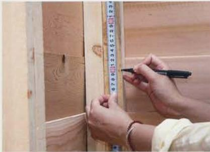
**8** 壁板、後壁板の3方向を立ち上げたら、棚受けを床から80cmの所に印を付けます。
