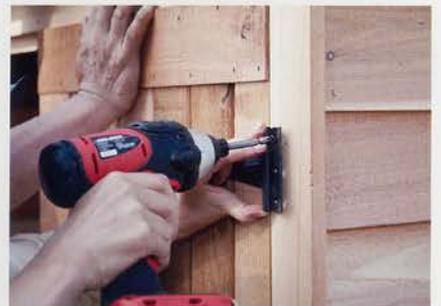
**22** 前面の屋根トリムに扉の上端がくるように左右の扉をそろえて取り付けます。
