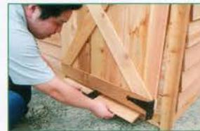
スムーズなドア開閉のために、ドア下側にスペースを設けること。ビス留め時に薄い板をドアの下に入れて作業しやすい
