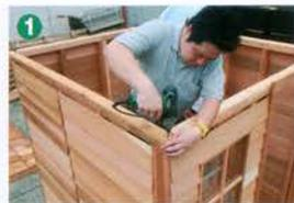
壁パネル同士をより強固に結束するために、トッププレートという材を壁の各辺に渡して固定
