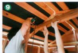
2枚の屋根パネルの間に補強用の添え板を渡してビスで固定する。これで構造体は完成だ
