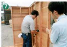
ビス打ちのときにパネルがズレないように、もうひとりがパネルを押しえてサポートしてあげよう
