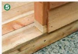
立てた2枚目の壁パネルを床パネルにビス留めする。床パネルの外側と壁パネルの面を合わせる
