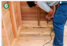
間柱と間柱の真ん中くらいの位置にビスを打って、床パネルに壁パネルを固定していく
