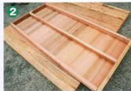
残りの壁パネルにもヘッダーを取り付ける。あとはこれを床パネルの上に立てていくのだ
