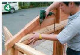
妻壁をトッププレートにビス留め。妻壁パネルには、納まりがいいように欠き込みが設けられている
