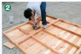
2枚の床パネルをビス留め。床面に段差ができないように高さをそろえ、等間隔で4カ所留める
