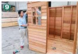
窓付きのパネルを立ち上げて、最後にドアの枠を取り付ければ、ひとまず壁づくりは終了だ
