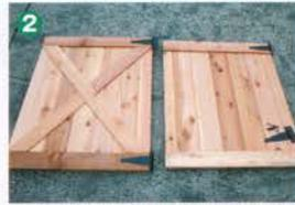
最初にドアに丁番を取り付ける。写真のように、ドアの片側4カ所にビスで留める
