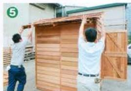
数人で屋根パネルを持ち上げて妻壁パネルに載せる。あとはズズリと押し上げていく
