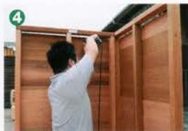
1枚目のパネルと角を合わせて2枚目のパネルをビス留め。等間隔で4カ所にビスを打って固定する
