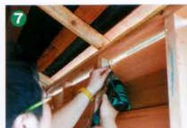
風などで屋根が落ちてしまわないように、トッププレートと屋根をビス留めして固定する
