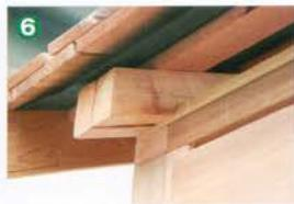
屋根パネルの材にも欠き込みがあるので、これがびったり納まるところまで押し上げる
