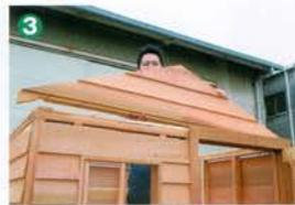
妻壁を設置する。妻壁も軽量なパネルに加工されているので、壁の上に持ち上げて固定すればOKだ
