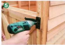
下のドアをドア枠に取り付ける。POINTで解説したように、ドアの下に薄い板を入れて作業する
