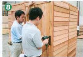
上下のドアが設置できたら、2枚のドアを固定して1枚ドアにする留め具を付ける
