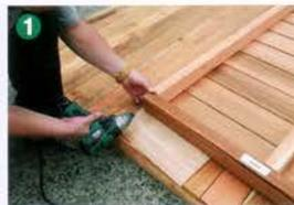
壁パネルにヘッダーといわれる材を取り付ける。このときビスは間柱に打つようにする
