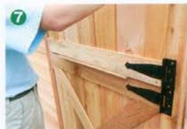
次に上のドアだ。ドア枠へのビス留めも、仮留めして位置を確認してから本締めする
