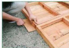
2枚のパネルを結合させるときには、高さをそろえて段差ができないように。薄い板などをパネルの下に入れて高さを合わせてからビス留めするとい
